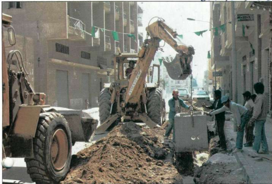
En mindre kabelbrunn sänks på plats i en gata i den lilla hamnstaden Derna. Här ses en bråkdel av Ericssons imponerande maskinpark för projektet.
