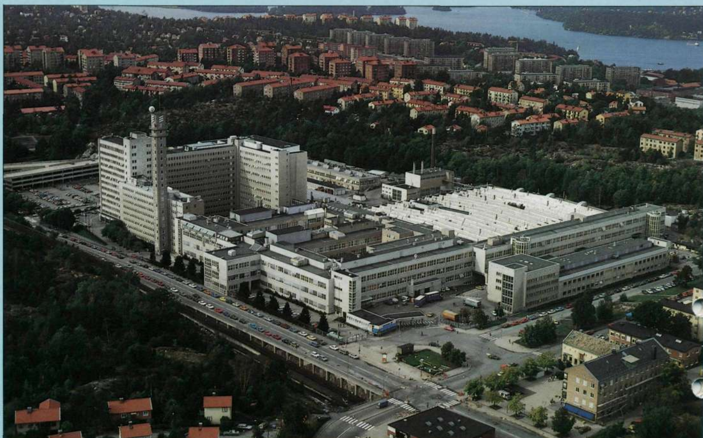
Ericssons huvudanläggning vid Telefonplan.
