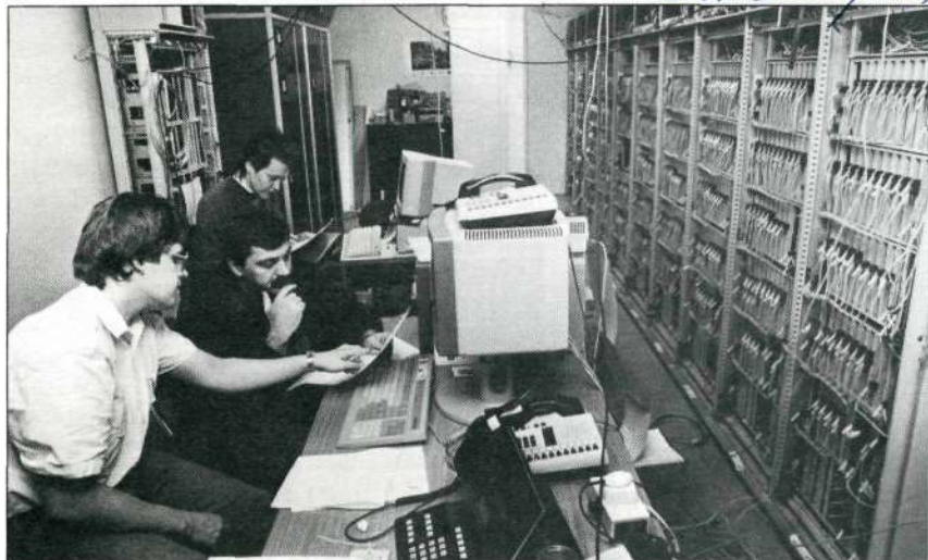
I påskhelgen gjordes överkopplingen när det gäller installationen av världens största MD 110.
