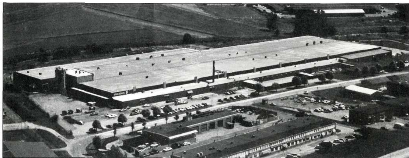
Den stora fabriksanläggningen är 25 000 m 2 . Men läget längst in i ett industriområde medverkar till att Ericsson ändå är ganska okänt i Kungsbäck.
