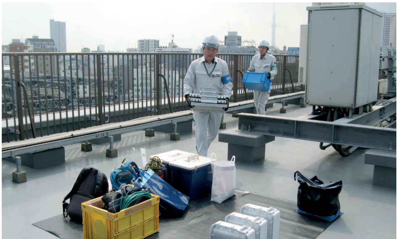
工程師在日本部署無線電設備，時刻留意屋頂作業環境是否安全。
