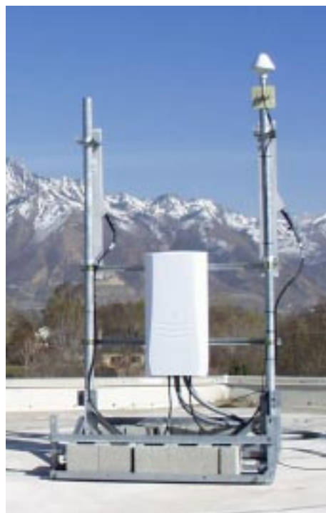
Figura 4 La RBS 1106 de Ericsson – configuración típica de instalación.
